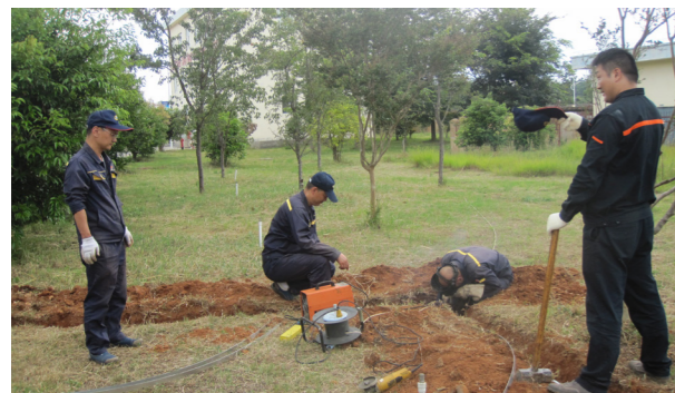
安宁公司武定分公司对防雷安全隐患进行排查, 并安装防雷设施
